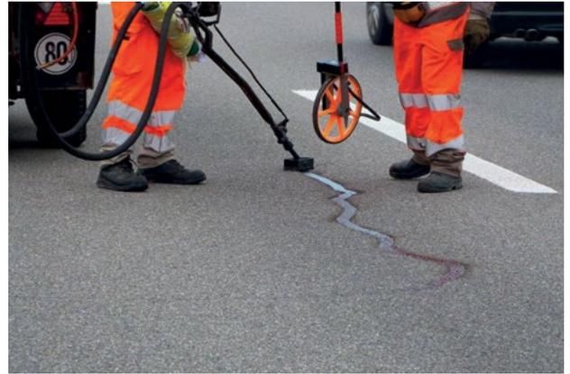
Par l'action des pressions exercées par le trafic routier, une fissure non réparée peut rapidement s'agrandir et créer, à terme, une désagrégation progressive de l'entier des couches du revêtement bitumineux.
