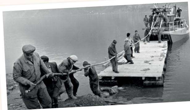
La construction du réseau avec des câbles en cuivre n'a rien eu de simple : en 1962, le village de Quinten à l'est de Zürich, par exemple, a été raccordé au réseau téléphonique par un câble en cuivre de 15 tonnes.
